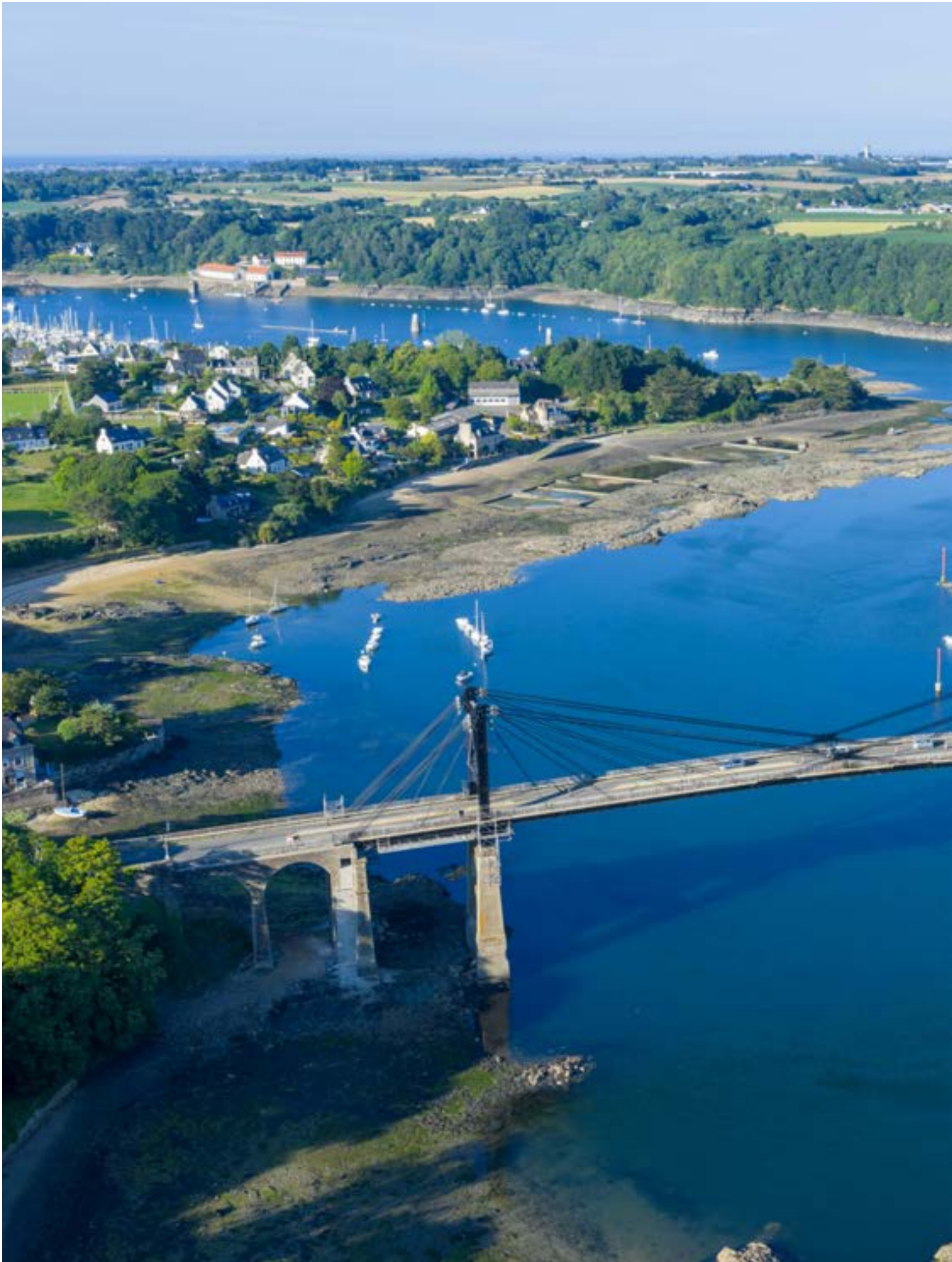
Pont Saint Christophe - Lézardrieux BAUDIN CHATEAUNEUF
