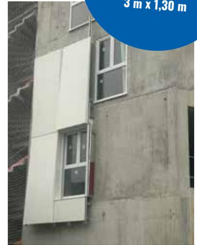
Un chantier inédit pour ROSAY, qui va poser un bardage en aluminium de forme trapézoïdale de 3 m x 1,30 m
