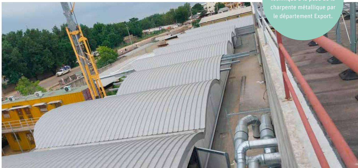
Fin des travaux de fourniture et d'assistance technique à la pose de la charpente métallique par le département Export.
