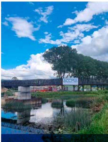
En groupement avec EST OUVRAGES, ACCMA a réalisé la pose de la passerelle à deux travées dans le cadre du projet d'aménagement d'une voie mobilité douce reliant Morteau et Montlebon. Cette passerelle, dotée d'une tôle de fond résinée, est ornée de garde-corps au motif de roseaux, s'intégrant harmonieusement dans le paysage. La pose s'est déroulée en deux phases à l'aide d'une grue mobile de 350t, les 4 et 11 juillet dernier.
