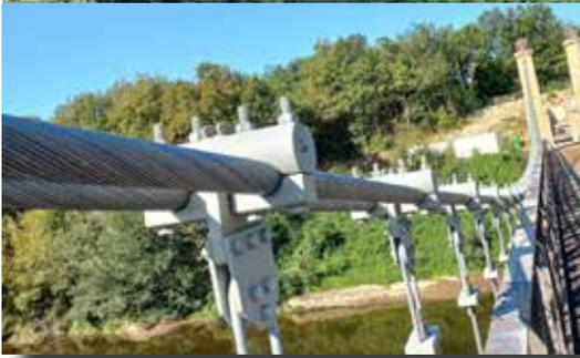
Dans le cadre de la réhabilitation du pont suspendu de TOUZAC, le Département Rénovation Ouvrages d'Art vient d'achever les travaux de remplacement de la suspension de l'ouvrage.
