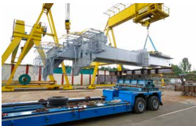
Chargement de la pièce sur la remorque du camion
