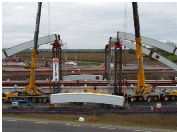
► Mise en place des clés d'arc
