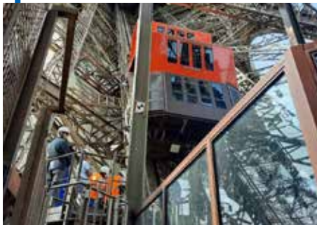
Juin 2023 – Mise en service
