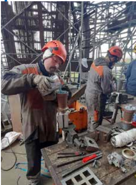
Avril 2023 – Tirage des câbles de traction de l'ascenseur
