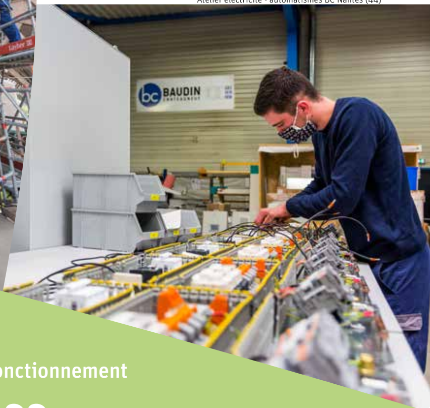
Atelier électricité - automatismes BC Nantes (44)
