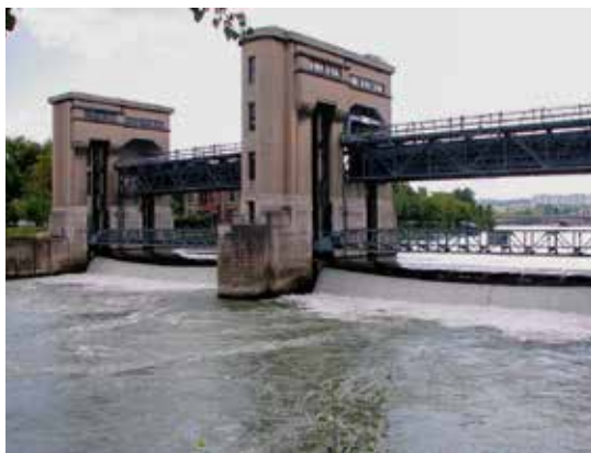
Barrage de SURESNES (92)
