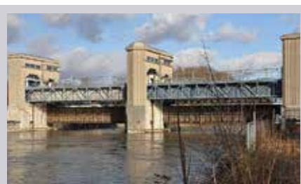
Barrage à vannes de SURESNES (92)
