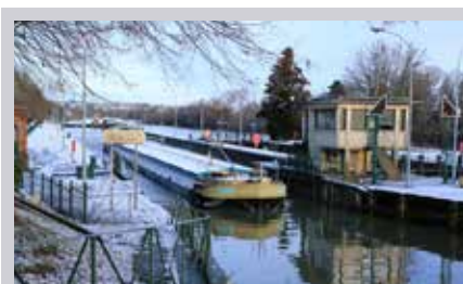
Modernisation des écluses de BOUGIVAL (78)
