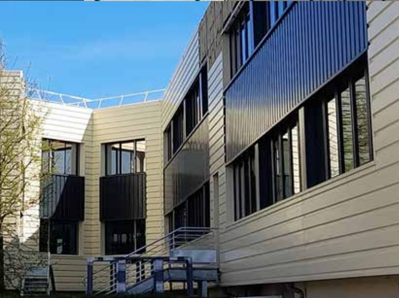
Siège BAUDIN CHATEAUNEUF - Bureaux Sud (45)
