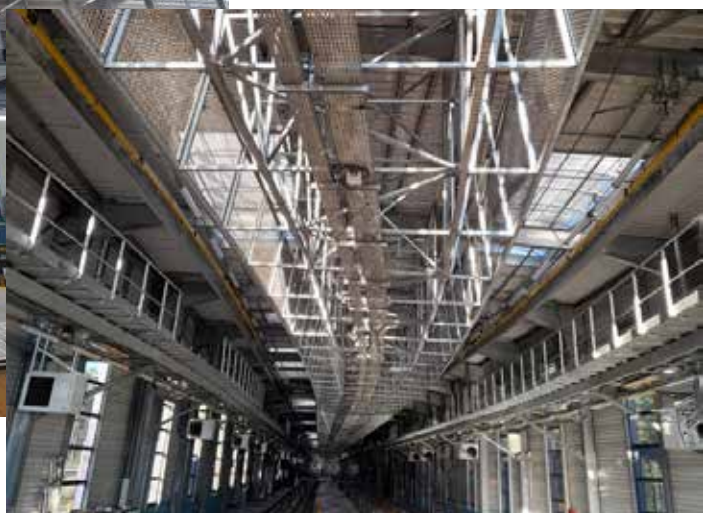
► Adaptation de l'atelier de maintenance des trains de Massy pour l'arrivée du MING - Lot 1.2 – Travaux de passerelle dans le Hall CDT (hall 2 voies)
