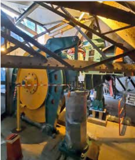
► JUIL-AOÛT 21 : RÉNOVATION MOTORISATION -SALLE DU TREUIL
