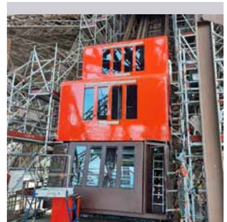
► AOÛT-SEPT 22 : MONTAGE DES CABINES
