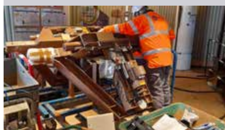
► AVRIL 22 : MONTAGE DES TAQUETS DE SÉCURITÉ AUX ÉTAGES
