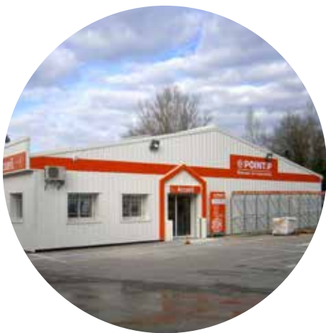
Réhabilitation POINT P VIDAUBAN (83)
