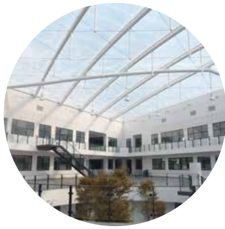
Centre de recherche HELIOS LVMH SAINT JEAN DE BRAYE (45)
