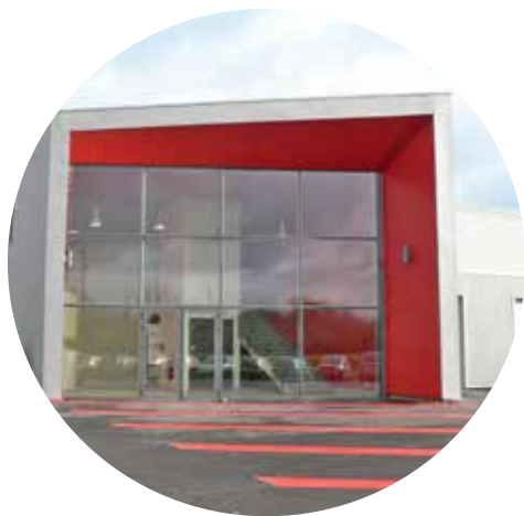
Centre logistique hospitalier TROYES (10)
