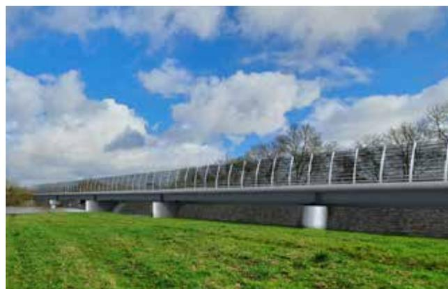
En groupement avec NGE GC / NGE Fondations / Agilis / Guintoli, ACCMA va réaliser la charpente métallique du viaduc sur l'Acheneau dans le cadre de la mise à 2X2 voies de la RD751. L'ouvrage fera environ 206 mètres de long et se situe entre les communes de Port-Saint-Père et Saint-léger-les-vignes, afin de faciliter le trafic routier entre Nantes et Pornic.
