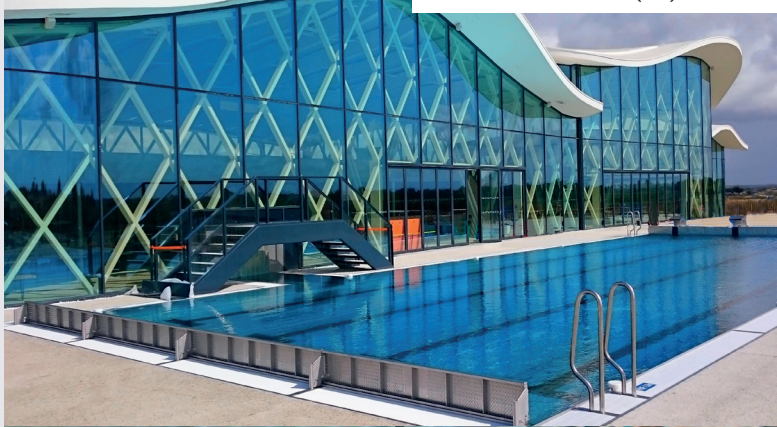
Piscine de SAINT GILLES CROIX DE VIE (85)
