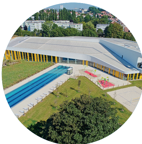
CENTRE AQUATIQUE OSMOSE GRAND LONGWY (54)
