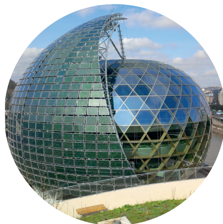
Voile photovoltaïque - Seine musicale BOULOGNE BILLANCOURT (92)
