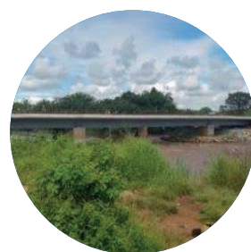
CAMEROUN Pont sur le Noun
