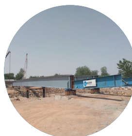
CAMEROUN Pont de Mizao
