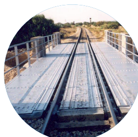
TUNISIE Réparation platelage pont ferroviaire SNCFT
