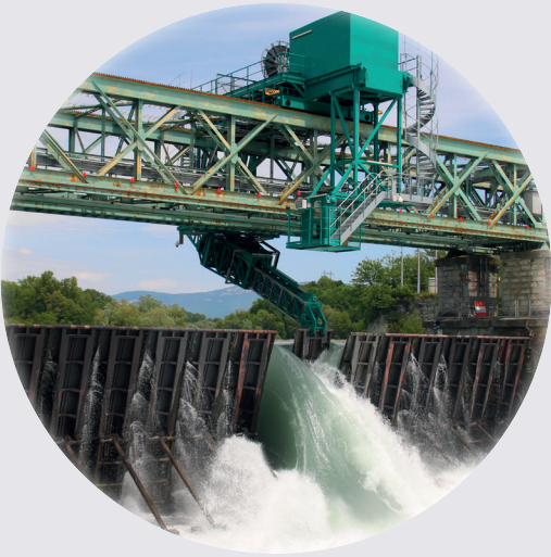
Barrage de Seyssel (74)
