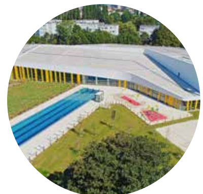
Centre aquatique Osmose Longwy (54)
