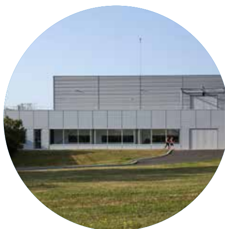
BIOMÉRIEUX BÂTIMENT 65 MARCY L'ÉTOILE (69)
