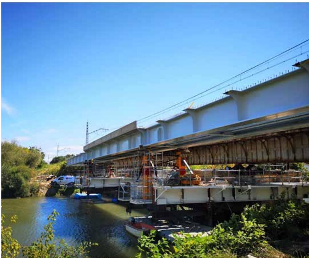
La Division Ouvrages d'art métalliques de BERHTOLD a procédé au remplacement du tablier du pont qui franchit la rivière "la Bidouze" au niveau de la ligne ferroviaire allant de Toulouse vers Bayonne. Ces travaux s'inscrivent dans le cadre de la politique de régénération des ouvrages d'art métalliques anciens de la SNCF.
