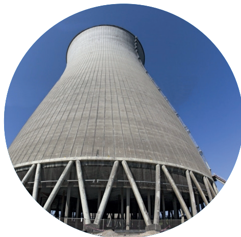
Réparation des aéroréfrigérants CNPE BUGEY (01)
