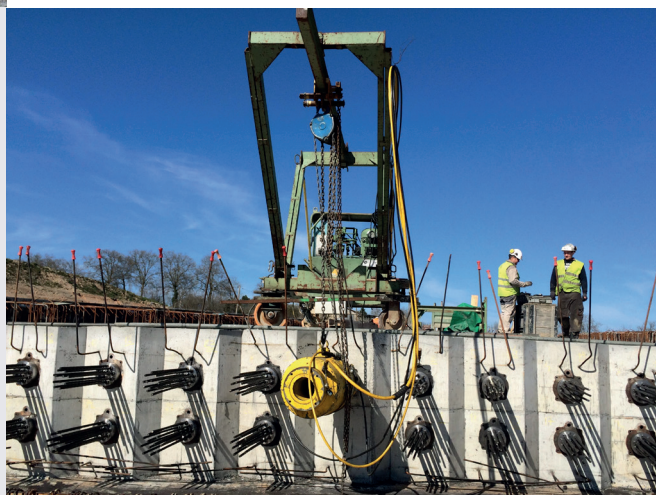
Précontrainte par post tension
