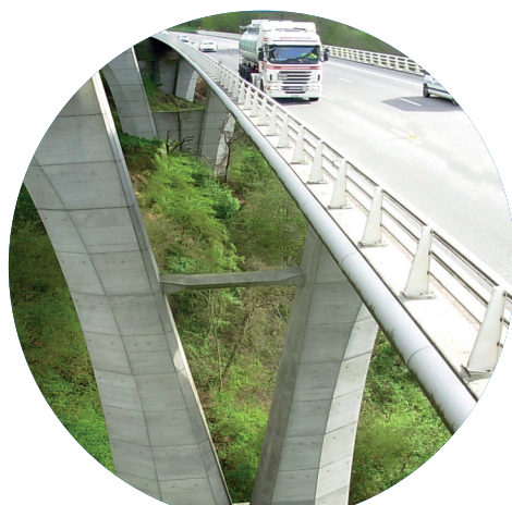
Remplacement joints de chaussée Viaduc de ROGERVILLE (76)
