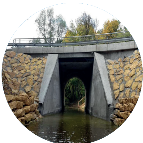
Réhabilitation du Pont Lebrun VALLEROY (54)
