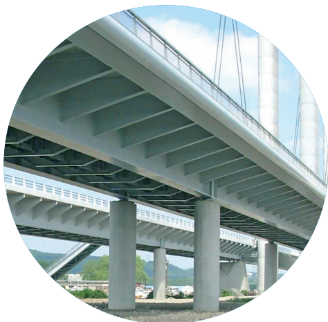
Viaduc d'accès au Pont Gustave Flaubert - ROUEN (76)
