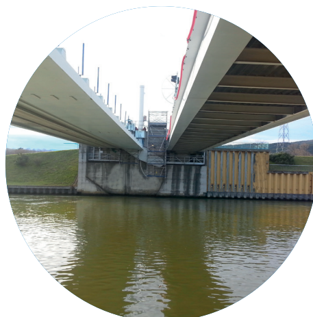
Renforcement de la vanne NPN Canal de DONZERE (82)
