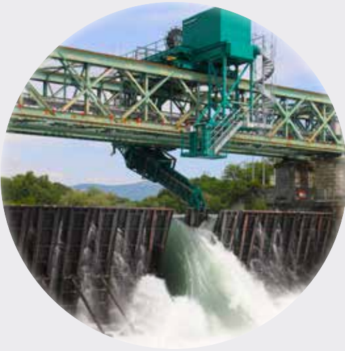
Barrage de Seyssel (74)
