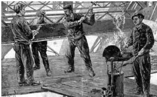
Pose de rivets lors de la construction de la Tour Eiffel
