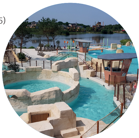
TRAITEMENT DES EAUX DE BAINADE DE L'AQUALAGON VILLAGE NATURE MARNE LA VALLÉE (77)
