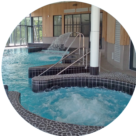
PISCINE DE DAMPIERRE EN BURLY (45)
