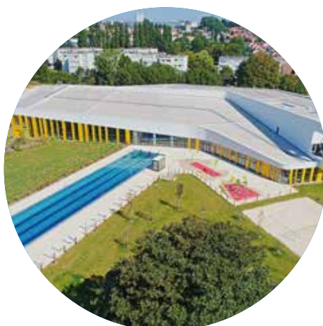
CENTRE AQUATIQUE OSMOSE GRAND LONGWY (54)
