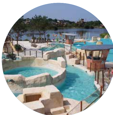
TRAITEMENT DES EAUX DE BAINNADE DE L'AQUALAGON VILLAGE NATURE MARNE LA VALLÉE (77)
