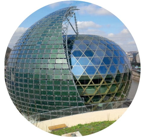
Voile photovoltaïque - Seine musicale BOULOGNE BILLANCOURT (92)
