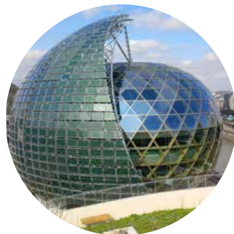
Voile photovoltaïque - Seine musicale BOULOGNE BILLANCOURT (92)
