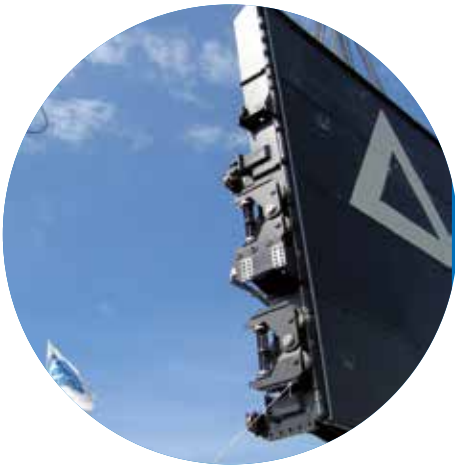
Écluse de Gerstheim Remplacement des portes aval levantes et des mécanismes de manœuvre (treuils à câbles).
