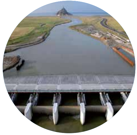
Mont - Saint - Michel Études et installation des nouveaux systèmes hydrauliques, vannes et passes à poissons du barrage du Couesnon.
