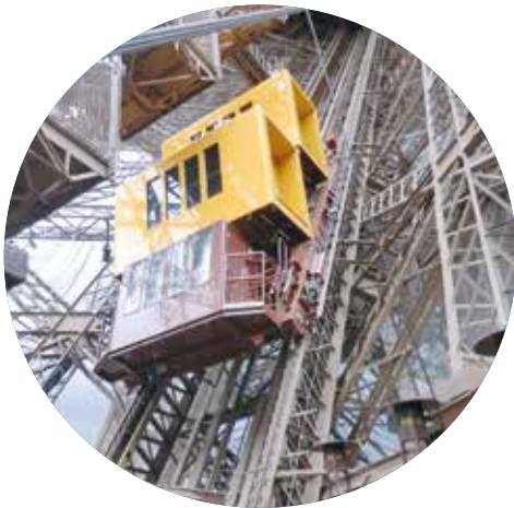
Tour Eiffel Rénovation et Certification CE de l'ascenseur Ouest.
