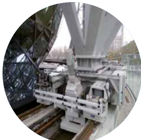
Voile photovoltaïque - Seine Musicale de l'île Seguin Construction d'une structure mobile de plus de 250 T circulant autour de l'Auditorium.
