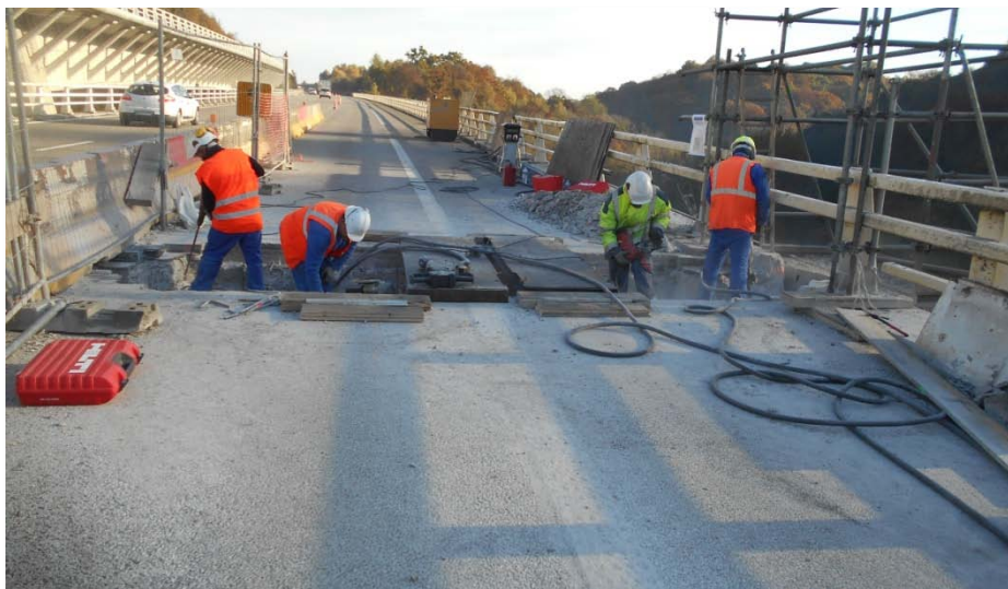
Préparation à la pose du joint phase 1
