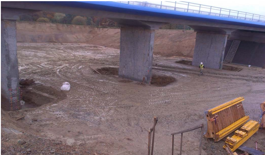
Ouvrage après terrassement et basculement de la voie ferrée
