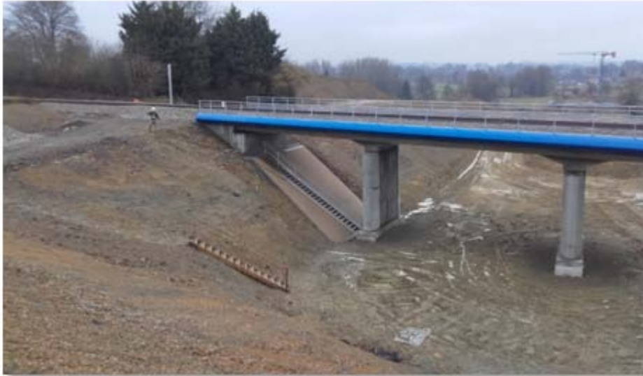
Ouvrage quasi terminé
