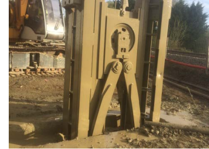
Réalisation des barrettes de fondation
