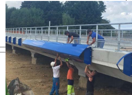
Mis en place des corniches métalliques avant basculement de la voie
