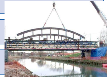
Démolition de l'ancien ouvrage
