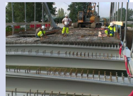
Pose des prédalles
