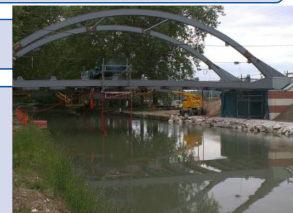
Montage de la charpente
