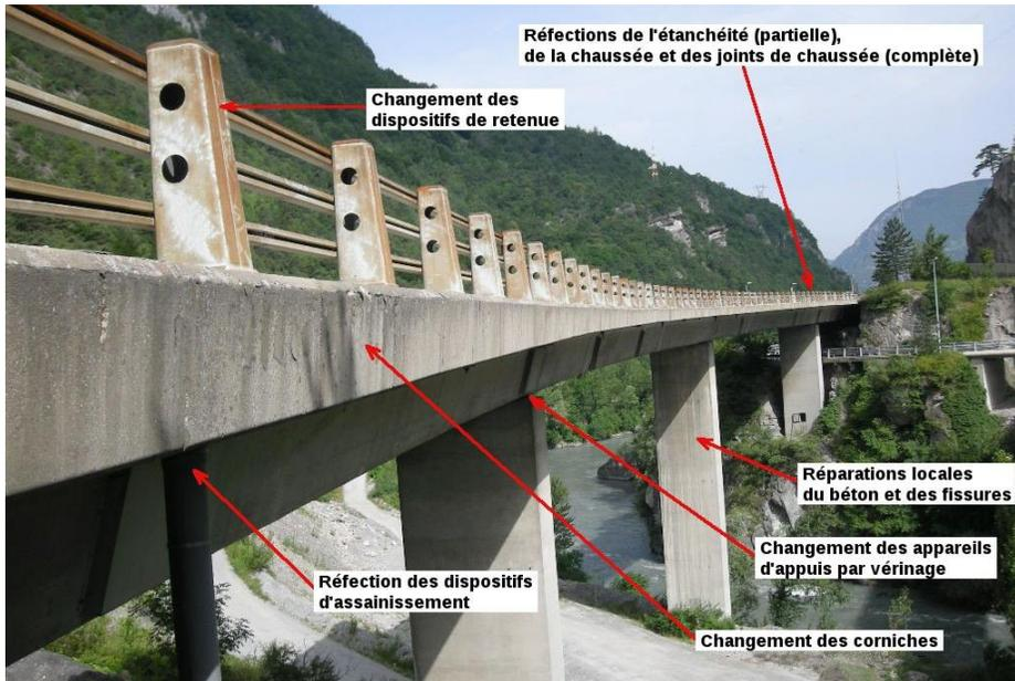
Réfections de l'étanchéité (partielle), de la chaussée et des joints de chaussée (complète)
