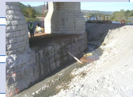
Reprise embase pile rive droite
