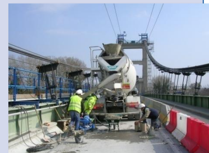
Reprise trottoir : bétonnage longrine de rive
