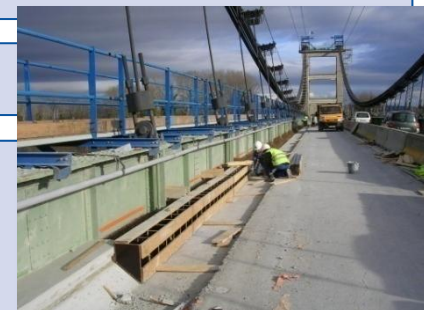
Reprise trottoir : coffrage longrine de rive
