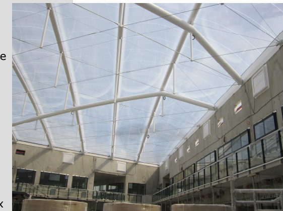
Poutres principales sous-tendues
