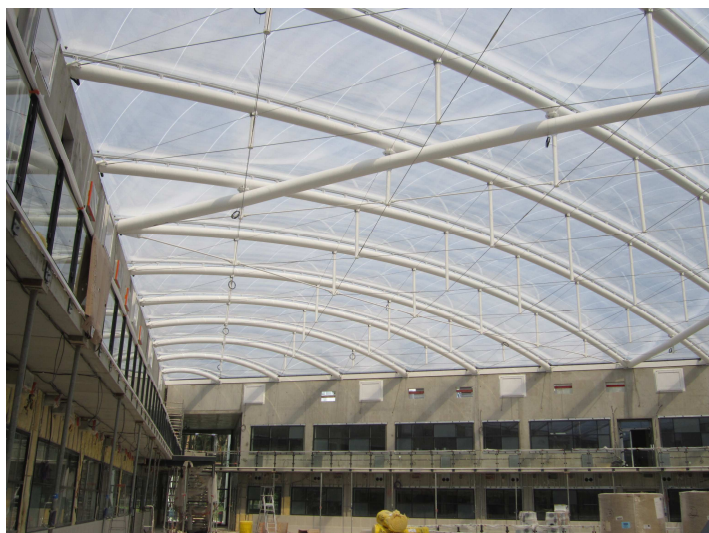
Vue générale – Poutre principale et pannes
