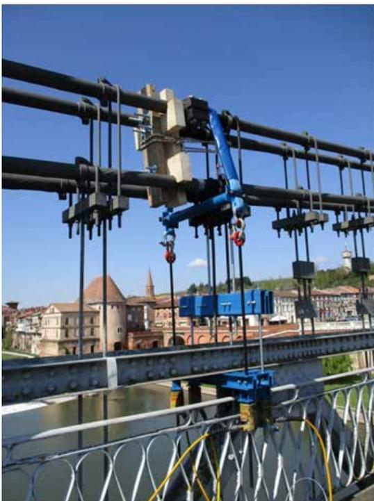
● suspente provisoire et chevêtre de vérinage mis en place pour le remplacement de suspente
