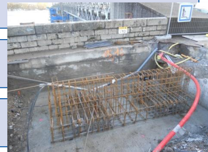
Construction culée rive droite
