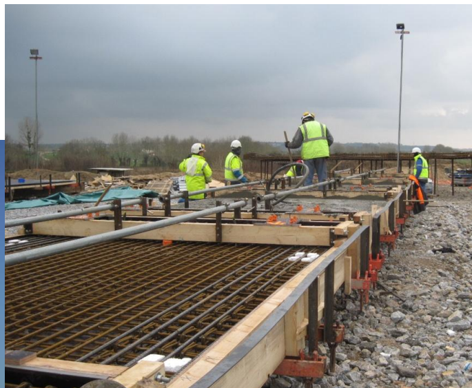
Banc de préfabrication des 140 dalles
