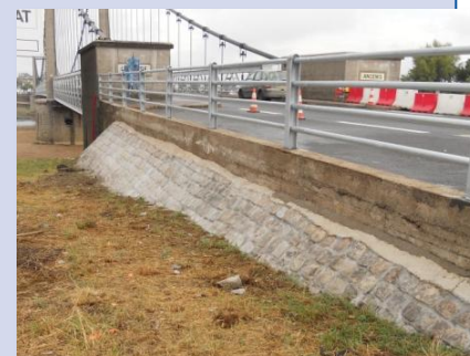
Rejointoiement perrés, remplacement garde-corps
