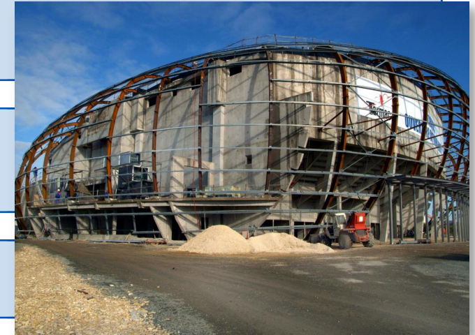
Montage de la charpente
