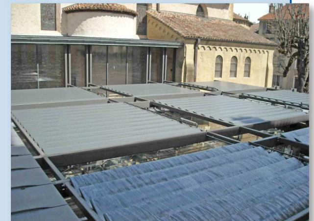
Mise en œuvre de brise-soleil motorisés au-dessus de la verrière
