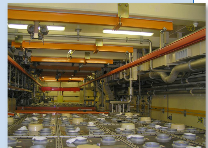
Boîte à gants sur site
