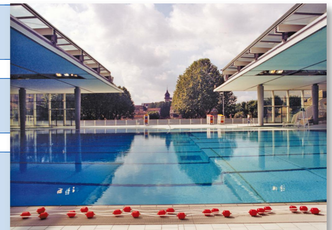
Toiture et façade ouverte
