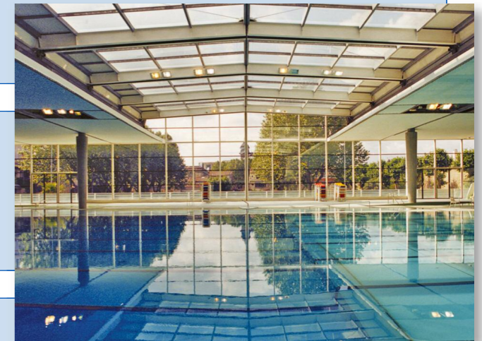
Toiture et façade fermée
