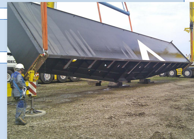
Manœuvre de retournement des pièces
