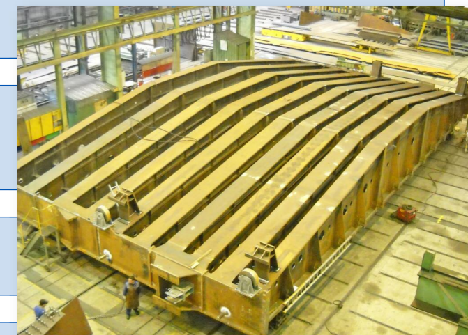
Montage à blanc dans nos ateliers de Châteauneuf-sur-Loire
