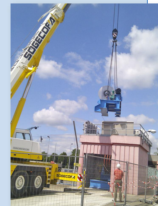
Mise en place des treuils
