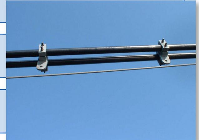
Le serrage du collier sur le câble et la gaine permet de garantir l'étanchéité
