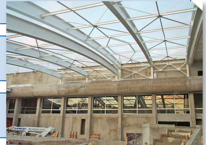
Portiques mobiles de la piscine en cours de montage
