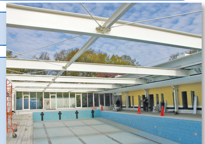
Toiture ouverte au-dessus du bassin
