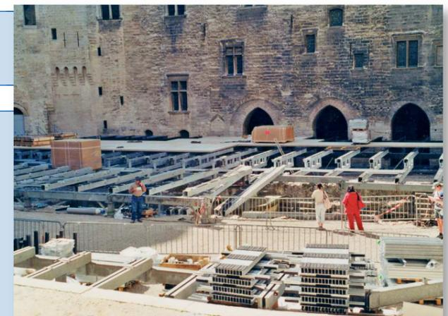
Plancher de scène et ossature des planchers de références en cours de montage
