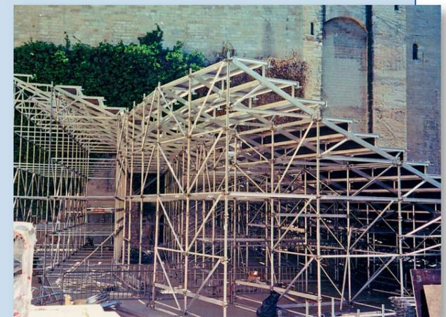
Ossature aluminium des gradins en cours de montage
