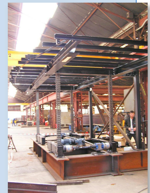
Montage de la structure porteuse en atelier
