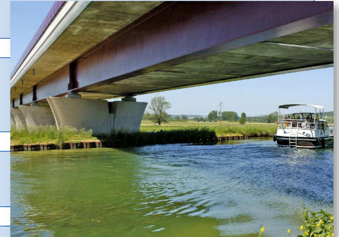
Viaduc sur le Canal de l'Est
