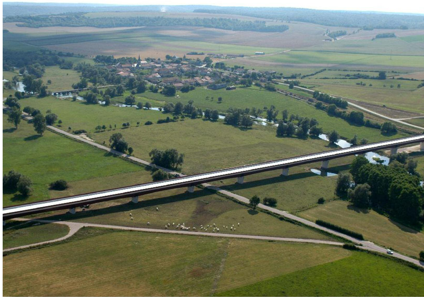
Viaduc sur la Meuse
