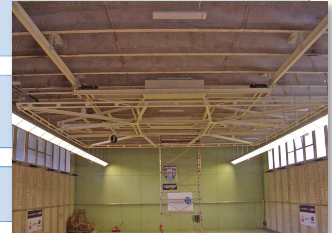
Structure repliée sous la toiture du bâtiment
