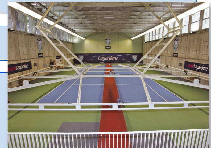
Structure déployée au sol
