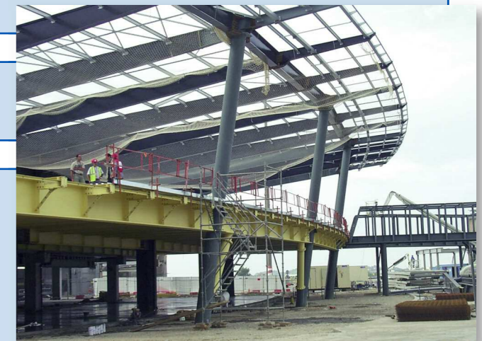
Extension piste en cours de montage
