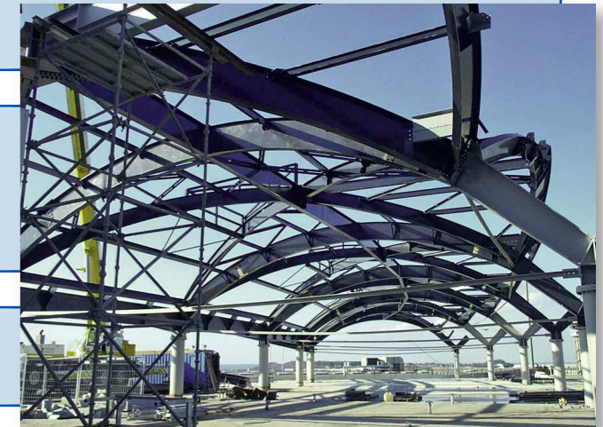
Extension ville en cours de montage
