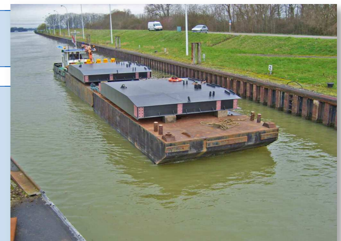
Acheminement par barges des vantaux
