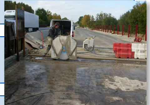
Sciage béton
