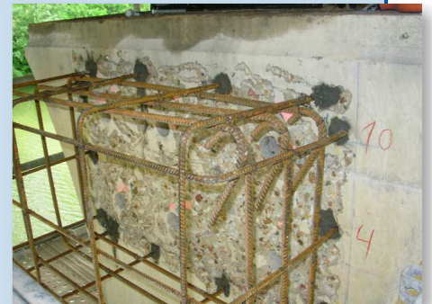
Création du massif de vérinage pour changement appareils d'appuis
