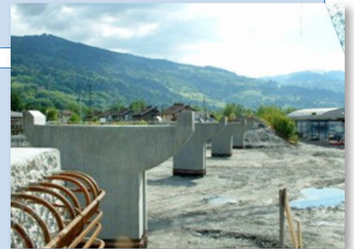
Vue des piles après bétonnage
