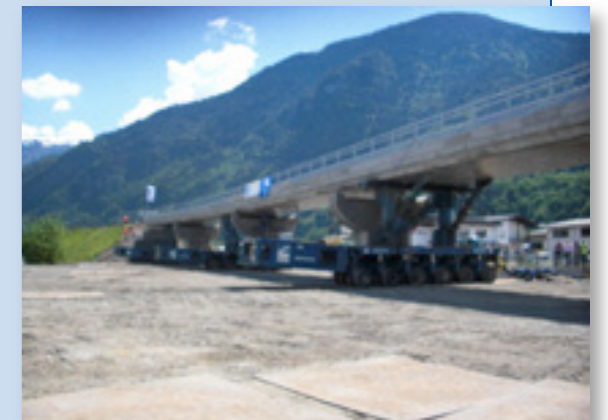
Mise en place de l'ouvrage
