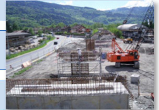
Ferrailage des piles
