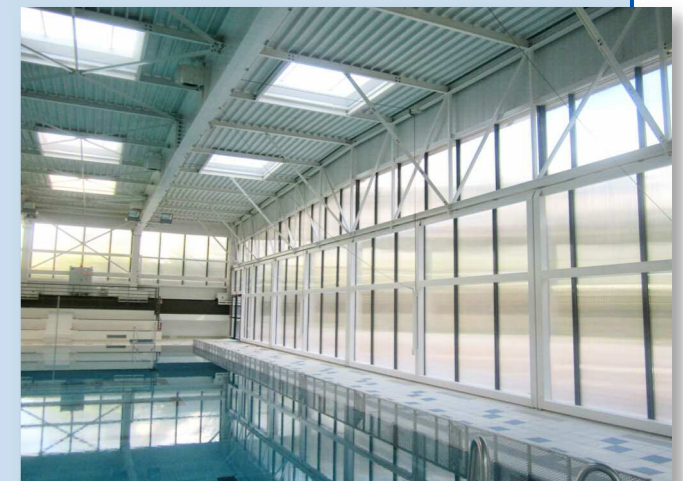
Panneaux relevables sous la poutre treillis du pignon de la toiture mobile 3
