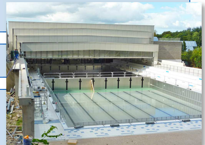
Éléments mobiles repliés sous la partie fixe
